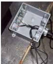
6. Fixer les câbles de basse tension à l'interrupteur - s'assurer de les fixer à la droite de l'interrupteur, ce qui facilitera le retrait de la 2nde borne de piles au moment de remplacer les piles. Fixer l'interrupteur à la droite du boîtier électrique, comme illustré ci-dessous.
