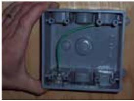
3. Retirer l'ouverture pré-perforée au centre du boîtier électrique et installer la borne de terre (l'écrou de la borne n'est pas requis).
