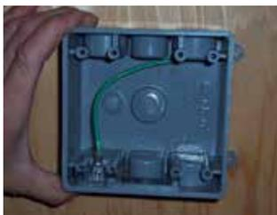
3. Retirer l'ouverture pré-perforée au centre du boîtier électrique et installer la borne de terre (l'écrou de la borne n'est pas requis).
