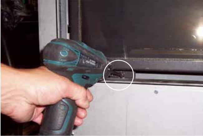
2) En utilisant les vis de cadre de porte existants, installez les supports de montage de maille inférieurs sur le côté gauche et côté droit, comme indiqué.
