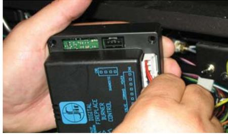
14) Fixer le boîtier de commande numérique au plancher de l'appareil à l'aide de la bande velcro.
