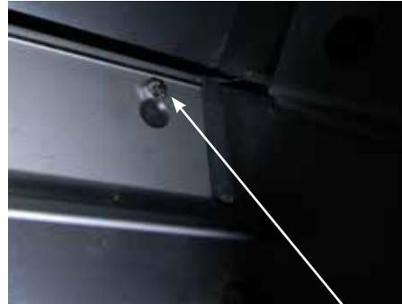
*S'assurer que le déflecteur est bien en place de manière à ce que les boulons soient placés sur le haut du trou en forme de serrure avant de serrer les boulons.*
