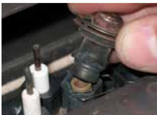
6) Dévisser l'orifice de la veilleuse à l'aide de la clé hexagonale Allen et le remplacer par l'orifice de la veilleuse au propane compris dans la trousse, puis remplacer la coiffe de la veilleuse.
