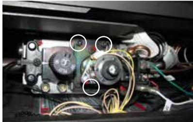
9. Soulever le capuchon de la veilleuse pour dégager l'orifice de la veilleuse.
