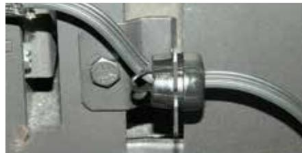
Fixer le dispositif anti-traction pré réglé
