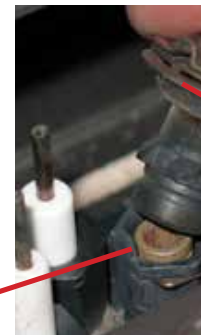
Orifice de la veilleuse
