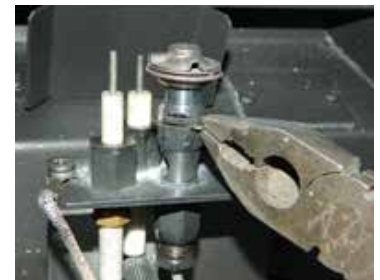
Schéma 3 - Emplacement des vis du brûleur
