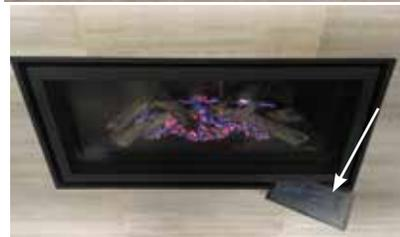
Retirer la façade et la porte extérieures (se reporter au manuel pour les instructions). Une fois la façade et la porte vitrée retirées, l'étiquette de sécurité est fixée à une chaîne.
