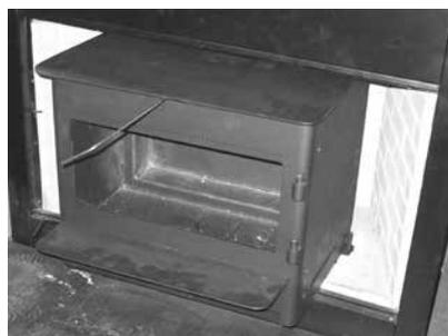
Schéma 5 Tige de traction en place
