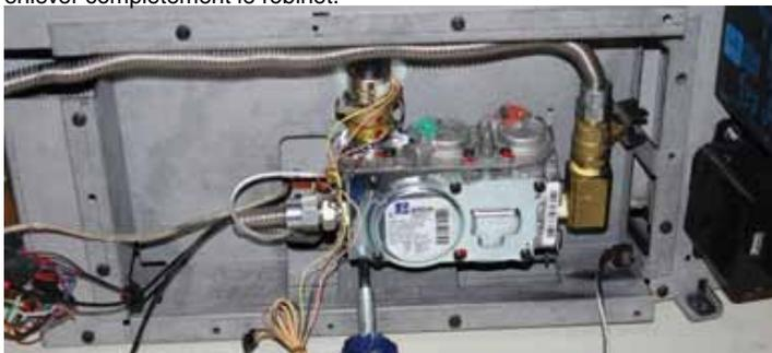
2) Retirez les deux vis qui securent les supports de montage soupape de gaz, des deux côtés. Soulevez le corps de soupape et le pencher vers l'extérieur. Les supports de soupape restent ouverte, comme représenté sur la droite.
