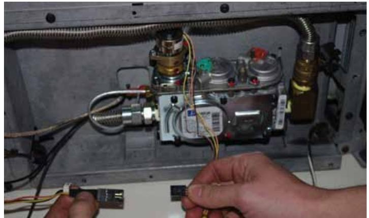
4) Enlever et jeter les 2 vis du régulateur de pression A (T20 ou à fente), le régulateur de pression B, le ressort et la membrane C.
