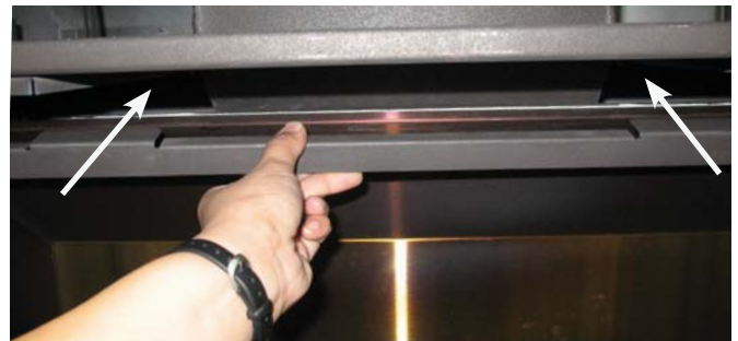
la ferrure de fixation supérieure installé avec les panneaux en acier inoxydable
