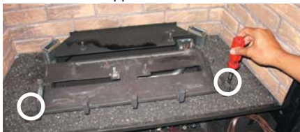
Schéma 1: Dévisser les deux vis de chaque côté du brûleur.
