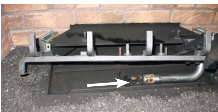
Schéma 2: Glisser le brûleur vers la droite et le soulever.
