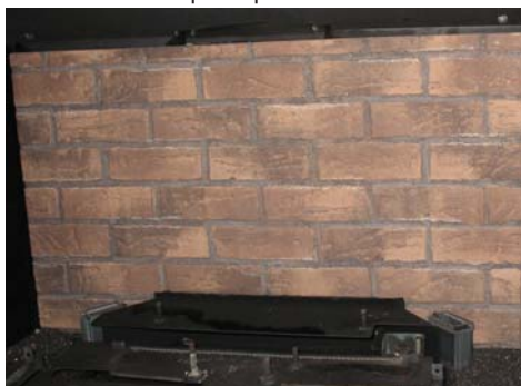
panneau du fond installé
