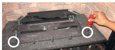
Schéma 1: Dévisser les deux vis du brûleur.
