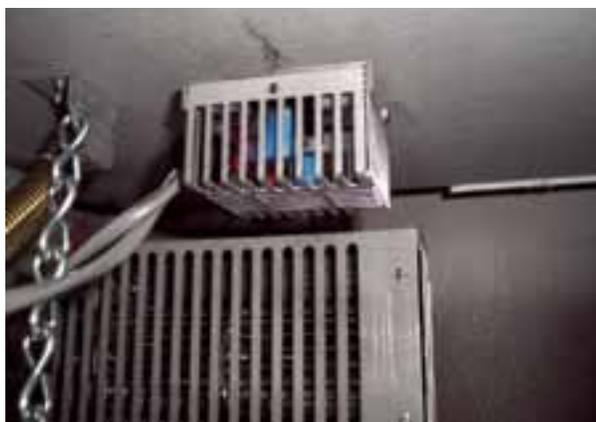
\* Assurer qu'il n'y a aucune interférence avec les fils quand le grille aération est fermé et qu'aucun fil ne touchera les surfaces à fonte ou les bords pointus.
