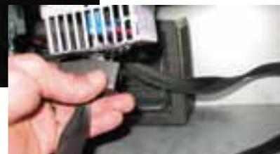
13) Installer chaque dispositif d'éclairage en passant sous le plancher de l'appareil et le fixer à l'aide de deux vis, tel qu'illustré ci-dessous.
