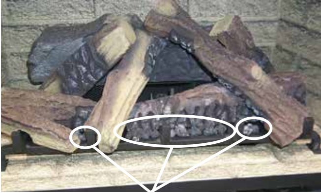
Placer les braises dans les trois emplacements sur le plateau du brûleur
