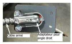
9. Installer le support dans le couvercle latéral. Avant l'installation, deux trous pourraient être percés à l'aide d'une point de 1/8 po en utilisant le support comme modèle.
