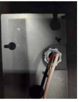
11. Brancher les fils de faisceau (X1) au câble armé à l'aide des 3 connecteurs de fils à torsion fournis. Faire les branchements selon les couleurs; neutre (blanc), sous-tension (noir) et fils de terre (vert et cuivre nu) entre le faisceau principal (X1) et le câble armé.
