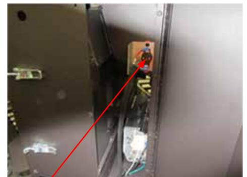
Emplacement de l'interrupteur de sécurité. Appuyez sur le bouton rouge pour réinitialiser.
