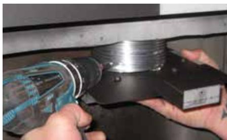
*Fixer la plaque coulissante au conduit flexible à l'aide de 4 vis/ rondelles (fournies).*
