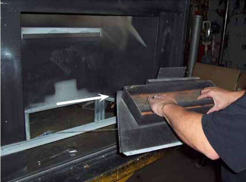
10. Retirer l'étiquette du numéro de série collée au dispositif de la valve et la fixer sur la paroi de la chambre de combustion du modèle 28C.
