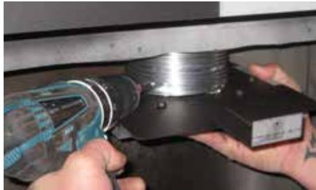
*Fixer la plaque coulissante du E18E au conduit flexible à l'aide de 4 vis/rondelles (fournies).*
