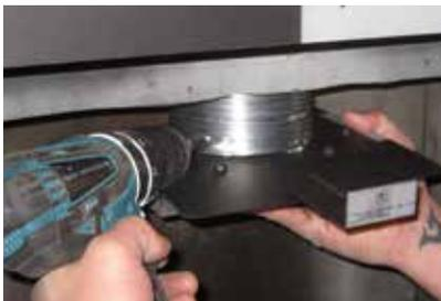
*Fixer la plaque coulissante du E18E au conduit flexible de 4 po (102 mm) à l'aide de 4 vis/rondelles (fournies).*
