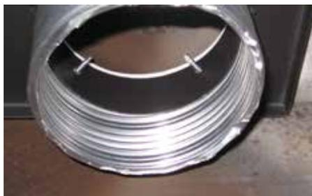
*Fixer la plaque de connexion à la chambre de combustion existante à l'aide de 4 vis/rondelles (fournies).*
