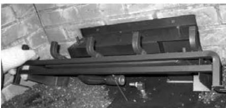
Dévisser les 2 vis, pousser le brûleur vers la gauche puis le soulever.
