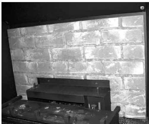
Panneau du fond une fois installé
