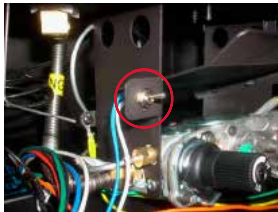
Le commutateur Surefire est situé au-dessus de la valve. Il est accessible en enlevant la grille d'aération/panneau inférieur.
