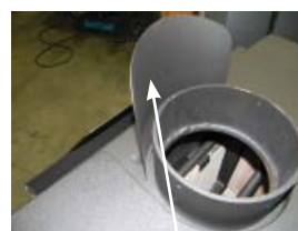
Bouclier thermique installé
