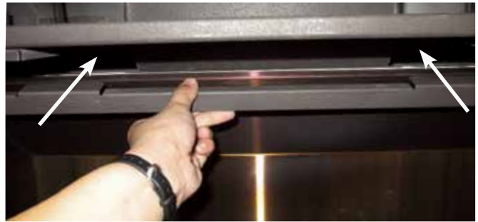
Ferrure de fixation du panneau supérieur installé avec les panneaux en acier inoxydable
