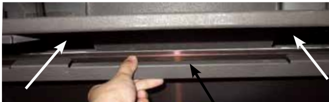
Ferrure de fixation du panneau supérieur
