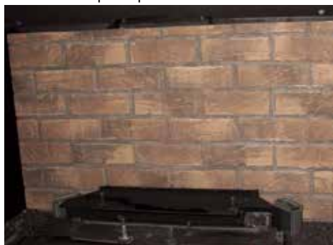
Panneau du fond une fois installé
