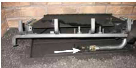
Schéma 2 : Glisser le brûleur vers la droite et le retirer.
