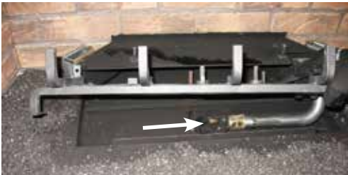
Schéma 2 : Glisser le brûleur vers la droite puis le retirer.
