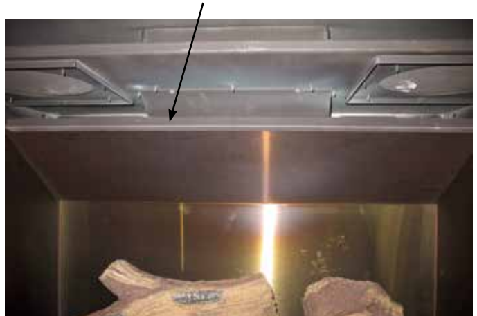
Ferrure de fixation du panneau supérieur installé avec les panneaux en acier inoxydable
