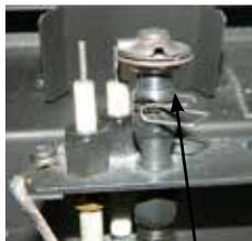
Attache de fixation de la veilleuse
