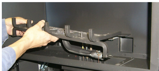
Schéma 1 : Ôter les vis sur la gauche et sur la droite puis soulever l'ensemble brûleur/grille pour le dégager.
