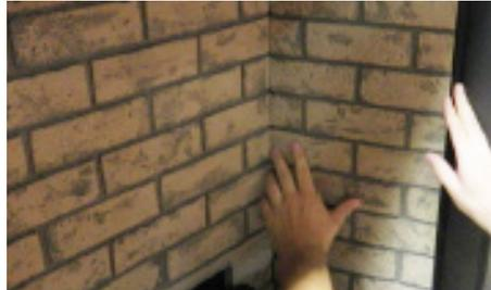
7. Une fois le panneau en place, le fixer à l'aide de l'attache à briques retirée à l'étape 5 et serrer la vis.
