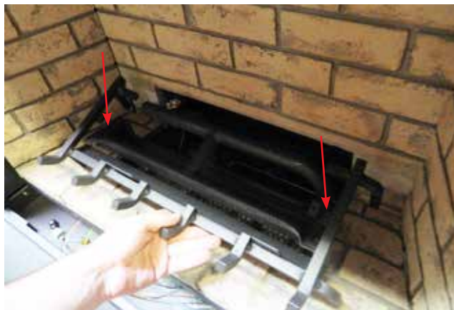
Schéma 2 - Installation du support de bûches
