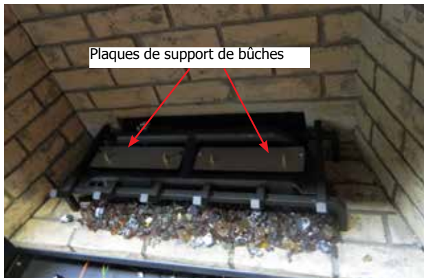
Schéma 6 - Plaques de support de bûches installées
