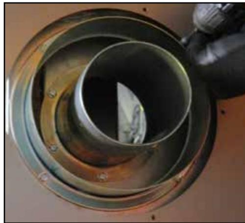
12. Réinstaller la plaque d'évacuation (retirée à l'étape 1) avec six (6) vis.
