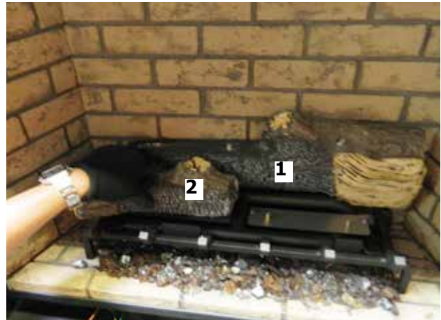
Schéma 8 - Installation de la bûche 2
