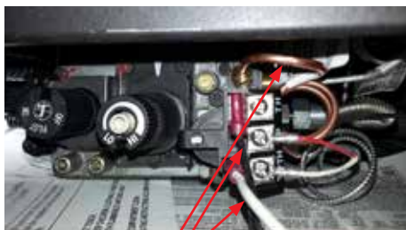
Schéma 4 Fils de l'interrupteur
