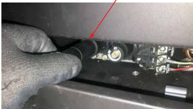
3. Suivre les consignes sur la façon d'allumer la veilleuse dans le présent manuel ou sur la plaque d'allumage située sous l'appareil.
