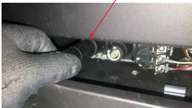
Extendeur glissé sur le bouton on/off/veilleuse sur la valve à gaz
