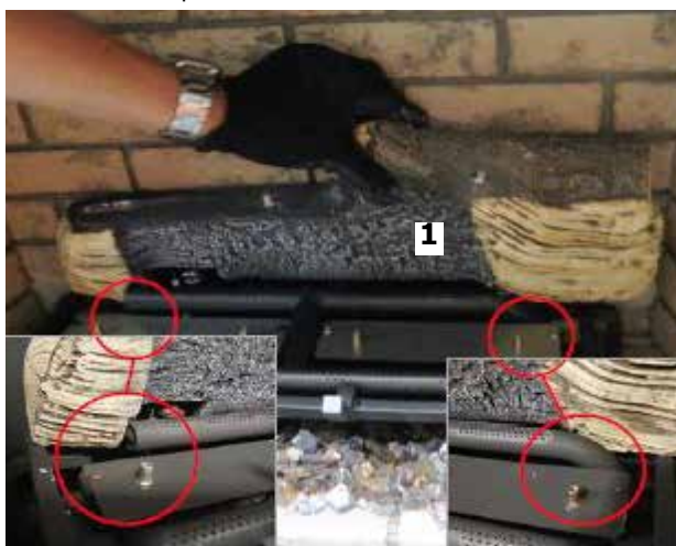
Schéma 7 - Installation de la bûche 1
