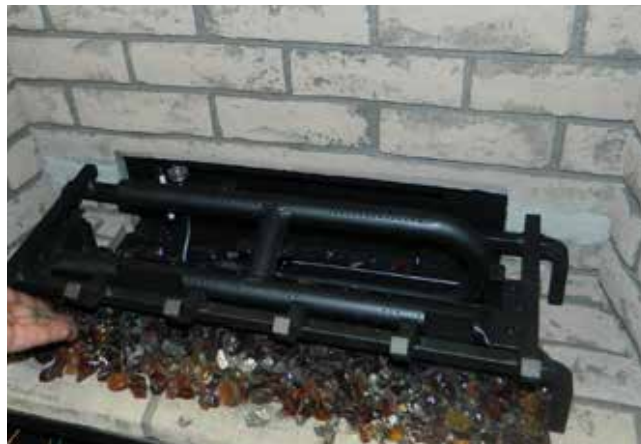
Schéma 4 - Installer la vermiculite et la lave
