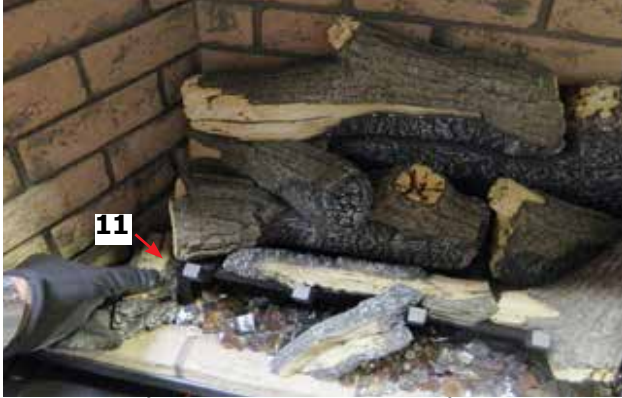
Schéma 17 - Installation de la bûche 11
