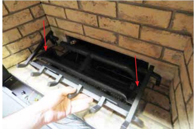
Schéma 2 - Installation du support de bûches
