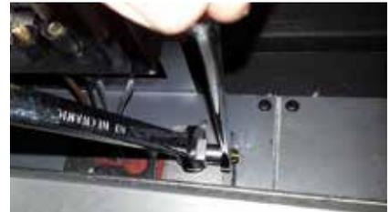
12. Réinstaller l'orifice du nouveau brûleur pour propane portant le numéro 53 et le serrer.
