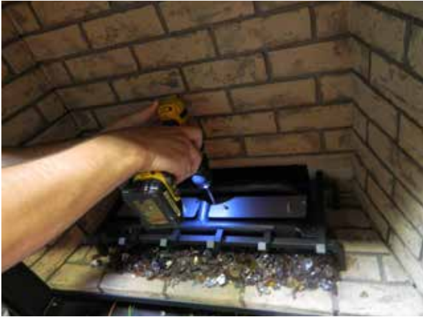
Schéma 5 - Installation des plaques de support de bûches
