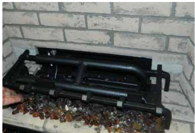
Schéma 4 - Installer la vermiculite et la lave
