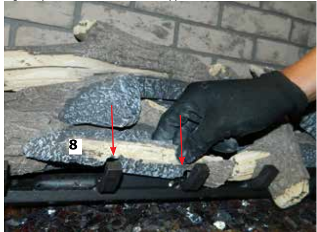
Schéma 14 - Installation de la bûche 8
