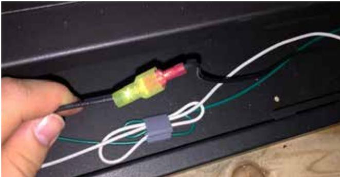
3. Coupez la connexion entre les connecteurs de fils en ligne sur le fil noir. Le câblage de l'interrupteur mural ou du thermostat sera acheminé vers ces deux connecteurs.
