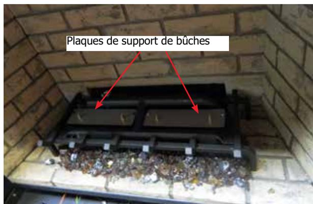
Schéma 6 - Plaques de support de bûches installées
