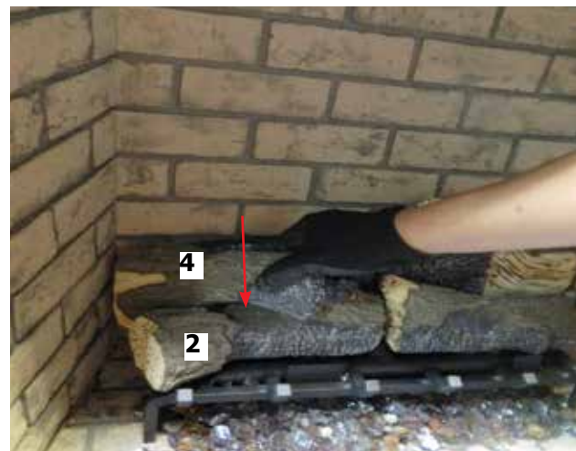
Schéma 10 - Installation de la bûche 4
