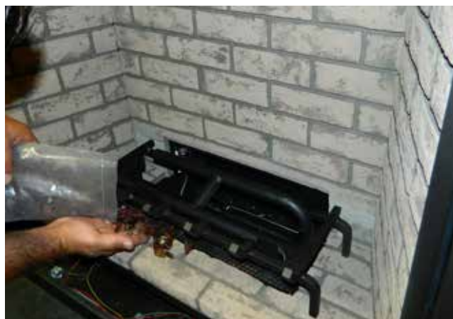
Schéma 3 - Installer les cristaux de verre
