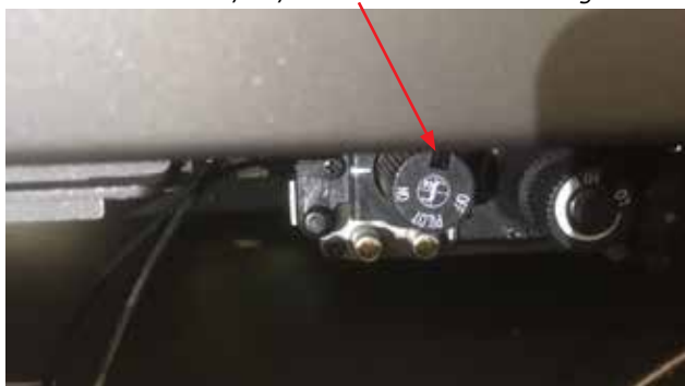
Extendeur glissé sur le bouton on/off/veilleuse sur la valve à gaz
