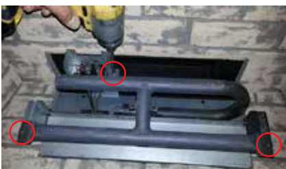
Schéma 2: Glisser le brûleur vers la droite puis l'enlever.
