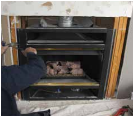
Retirer l'appareil de la structure
