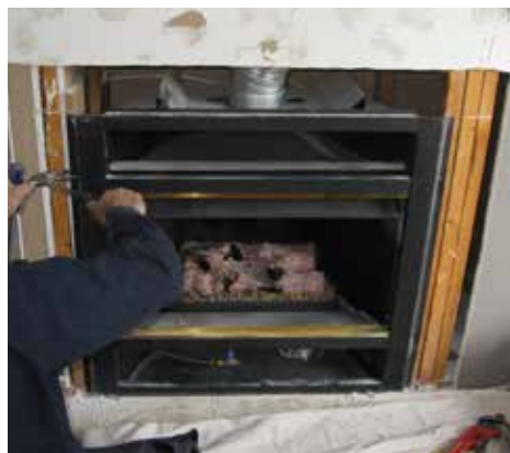
Retirer l'appareil de la structure d'encadrement
