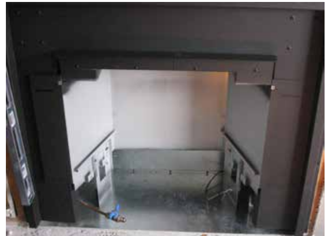
Illustration de la chambre de combustion extérieure en place - se reporter aux mesures (étape 18) avant de fixer le contour.
