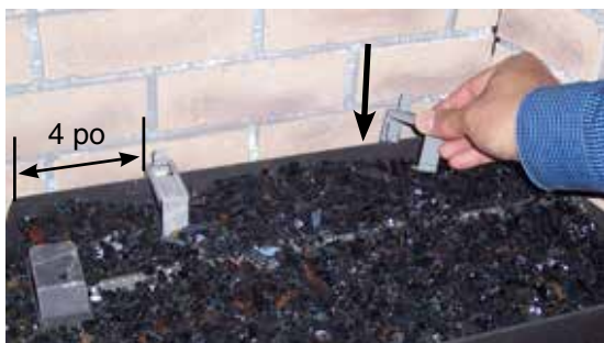
Installation des ferrures de fixation à 4 po à partir du bord extérieur du plateau du brûleur
