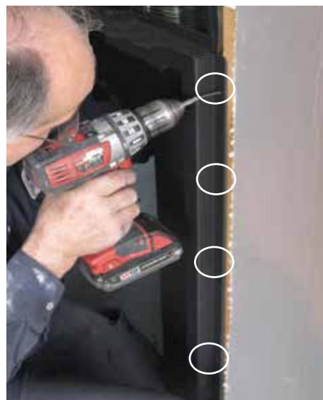
Utiliser 4 vis de chaque côté pour fixer le contour aux montants.
