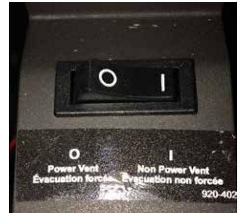
**REMARQUE** Ce commutateur doit être mis en place au moment de l'installation et ne doit jamais devoir être déplacé d'un emplacement à l'autre. Ce commutateur est caché pour éviter que le propriétaire ne le place dans la mauvaise position.
