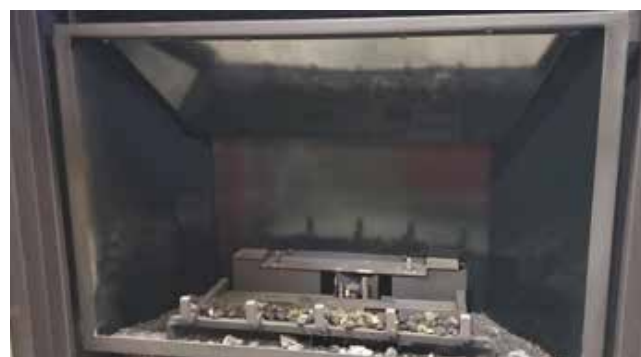
Schéma 7 - Installation complète des panneaux
