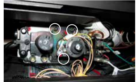
Retirer le moteur pas-à-pas pour gaz naturel et le remplacer par le moteur pas-à-pas pour propane
