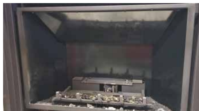
Schéma 7 - Installation complète des panneaux
