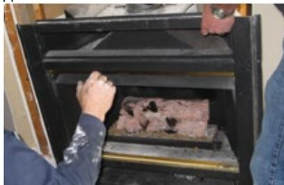
10. Mesurer l'ouverture d'encadrement et comparer aux dimensions nécessaires pour la structure DN (indiquées ci-dessous). **Enlever la traverse en bois au-dessus du foyer et la remplacer par la traverse en acier fournie.** Cette traverse est plus longue que l'ouverture d'encadrement : l'ajuster avant de l'installer. D'autres ajustements de l'ouverture d'encadrement seront peut-être nécessaires.
