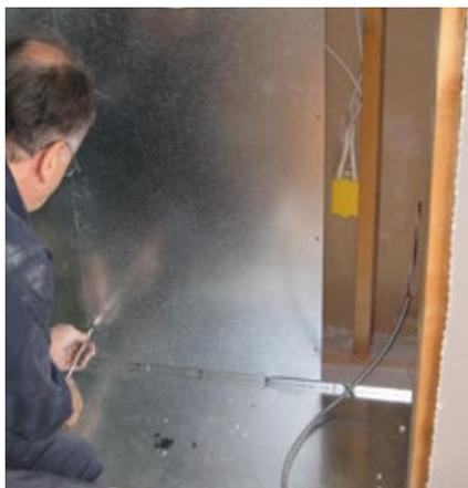
Assembler les sections du caisson DN à l'aide des vis fournies.
