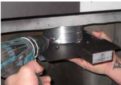
Fixer la plaque coulissante au conduit flexible à l'aide de 4 vis.
