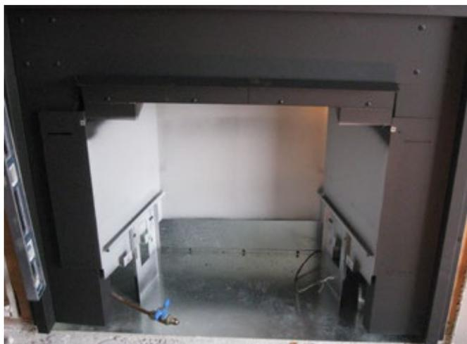
Chambre de combustion externe une fois en place - vérifier les mesures (étape 22) avant de la fixer au contour.
