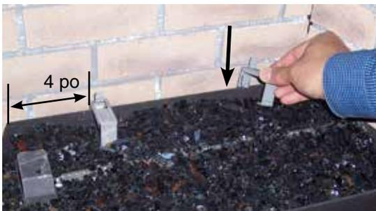
Installation des ferrures de fixation à 4 po à partir du bord extérieur du plateau du
