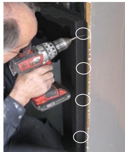
Utiliser 4 vis de chaque côté pour fixer le contour et le caisson DN aux montants.
