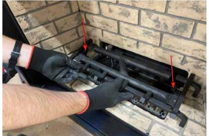
Schéma 2 - Installation du support de bûches
