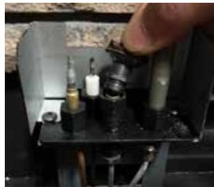
9. Dévisser l'orifice de la veilleuse avec la clé hexagonale Allen. Le remplacer par l'orifice de la veilleuse pour propane fourni dans le kit.
