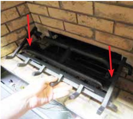
Schéma 1: Retirer les vis à gauche et à droite.
