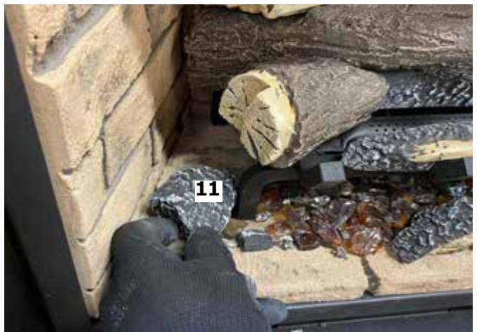
Schéma 16 - Installation de la bûche 11
