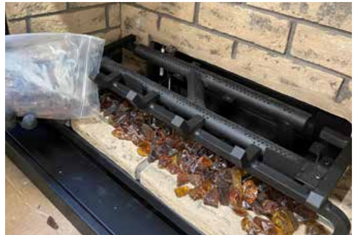
Schéma 3 - Installer les cristaux de verre
