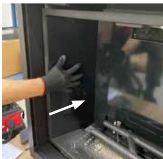
9. Glisser soigneusement le panneau inférieur sous le brûleur et le pousser vers l'arrière jusqu'à ce qu'il entre en contact avec le panneau arrière.
