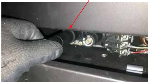
Extendeur glissé sur le bouton on/off/veilleuse sur la valve à gaz
