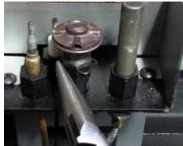
Attache de retenue de la veilleuse
