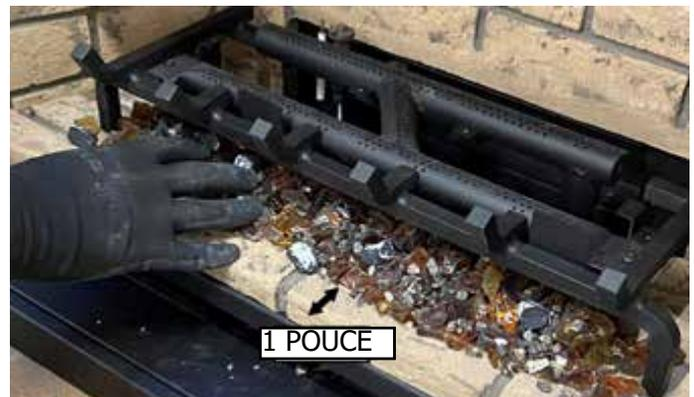
Schéma 4 - Installer la vermiculite et la lave
