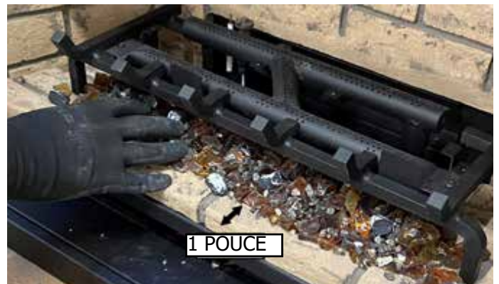
Schéma 4 - Installer la vermiculite et la lave
