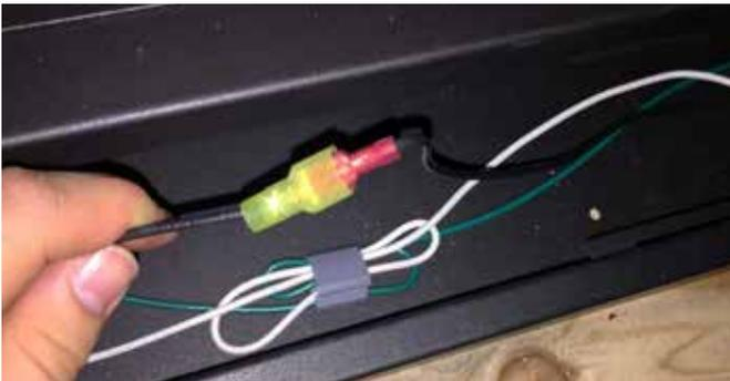
3. Couper la connexion entre les connecteurs de fils en ligne sur le fil noir. Le câblage de l'interrupteur mural ou du thermostat sera acheminé vers ces deux connecteurs.
