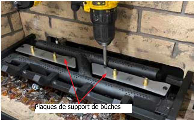
Schéma 5 - Installer les plaques de support des bûches
