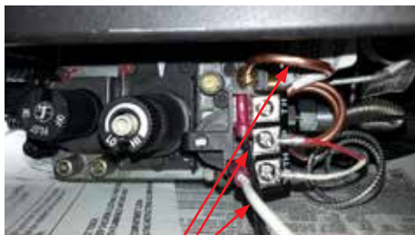
Schéma 4 Fils de l'interrupteur
