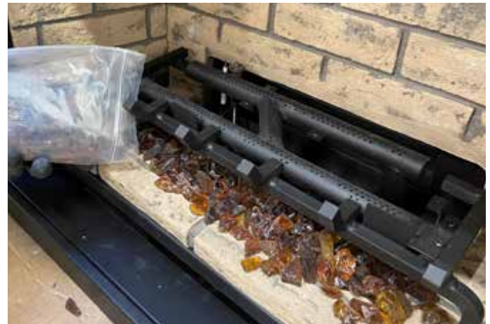
Schéma 3 - Installer les cristaux de verre
