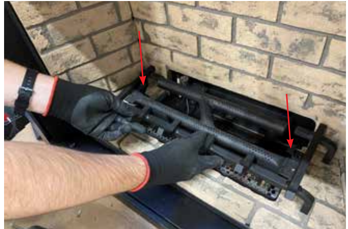
Schéma 2 - Installation du support de bûches
