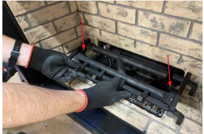
Schéma 2 - Installation du support de bûches
