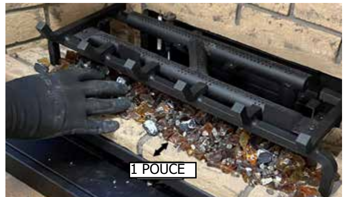
Schéma 4 - Installer la vermiculite et la lave
