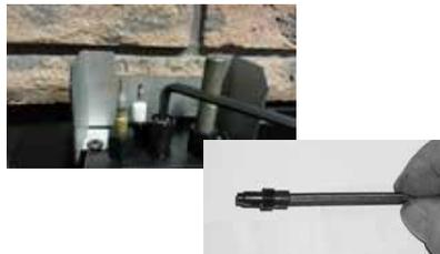
10. Réinstaller le capuchon de la veilleuse et l'attache de retenue de la veilleuse.
