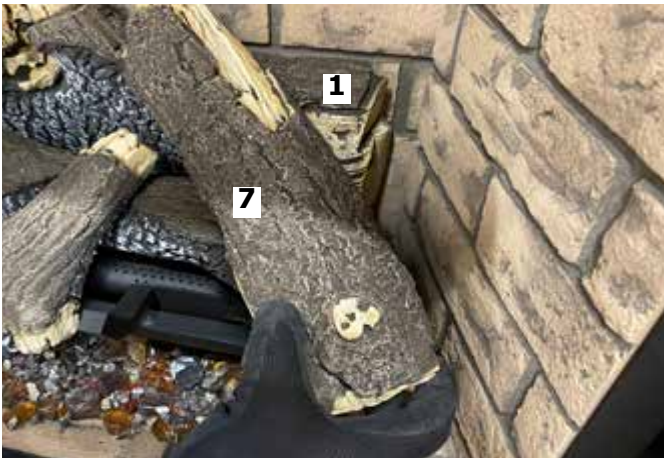
Schéma 12 - Installation de la bûche 7
