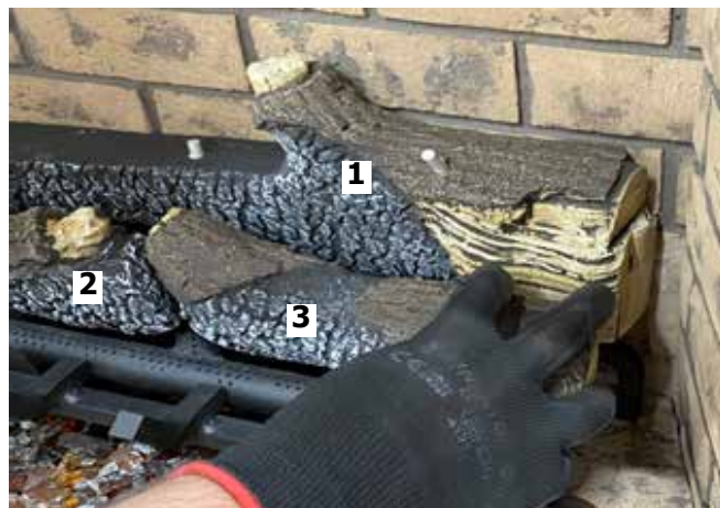
Schéma 8 - Installation de la bûche 3
