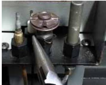
8. Détacher le capuchon pour exposer l'orifice de la veilleuse.
