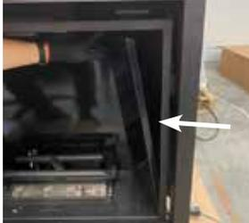
7. Une fois le panneau en place, le fixer à l'aide de l'attache à briques retirée à l'étape 5 et serrer la vis.
