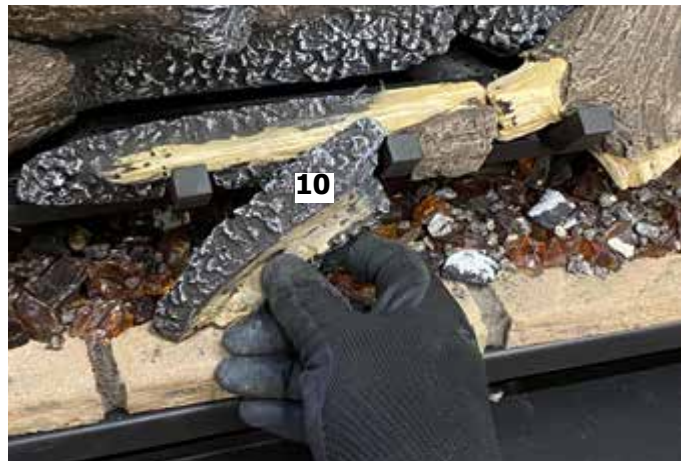
Schéma 15 - Installation de la bûche 10
