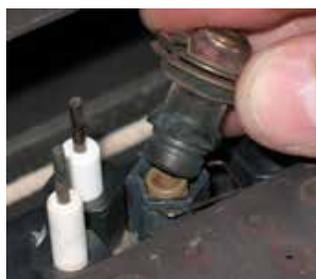
15. Dévisser l'orifice de la veilleuse à l'aide d'une clé hexagonale Allen, puis le remplacer avec l'orifice de la veilleuse LPG et le capuchon de la veilleuse fournis dans la trousse.
