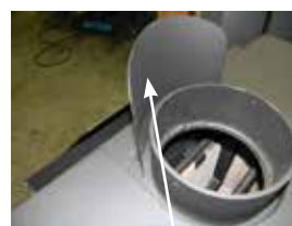
Bouclier thermique installé
