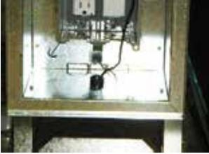
6. Faire courir le câble de l'adaptateur pour courant alternatif AC depuis le boîtier électrique récemment installé jusqu'à l'arrière de l'extrémité de l'appareil.
