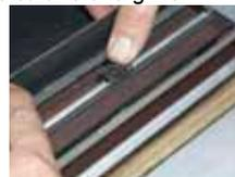
11) Visser le module à la grille à l'aide de deux vis à gauche et d'une vis à droite.
