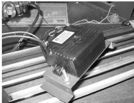
30) Brancher le fil de mise à la terre au support de fixation du dispositif d'allumage.
