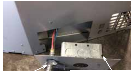
Câble armé évacuation forcée PV Boîtier de prise métallique pour alimentation 120 V
