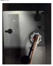
12. Brancher les fils de faisceau (X1) au câble armé à l'aide des 3 connecteurs de fils à torsion fournis. Faire les branchements selon les couleurs; neutre (blanc), sous-tension (noir) et fils de terre (vert et cuivre nu) entre le faisceau principal (X1) et le câble armé.
