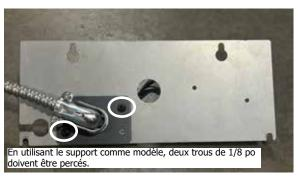
11. Verrouiller le connecteur droit à l'aide de la pince de verrouillage ou du connecteur fourni.
