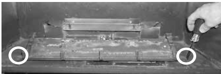
Dévisser les 2 vis, pousser le brûleur vers la gauche puis le soulever.
