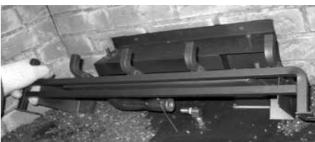
Dévisser les 2 vis, pousser le brûleur vers la gauche puis le soulever.
