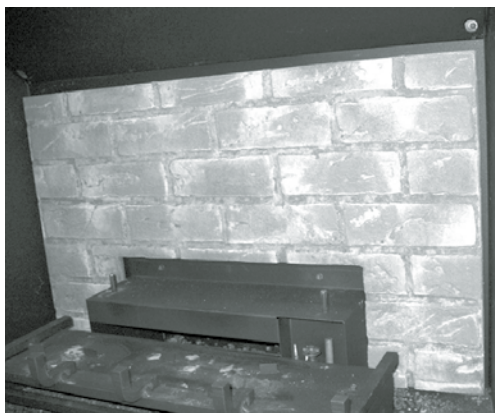
Panneau du fond une fois installé
