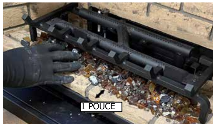
Schéma 3 - Installer les cristaux de verre
