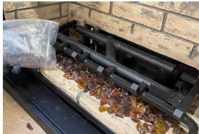
Schéma 3 - Installer les cristaux de verre
