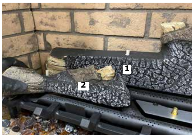
Schéma 7 - Installation de la bûche 2
