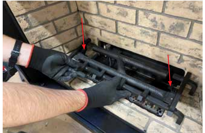
Schéma 2 - Installation du support de bûches
