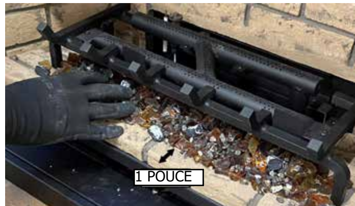
Schéma 4 - Installer la vermiculite et la lave Avertissement : Les cristaux de verre doivent être placés à au moins 1 po du rebord avant de l'appareil.
