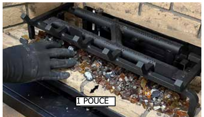
Schéma 3 - Installer les cristaux de verre
