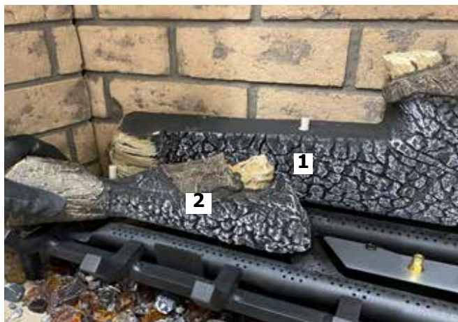
Schéma 7 - Installation de la bûche 2
