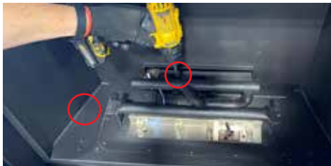
Schéma 2 : Glisser le brûleur vers la droite et l'enlever
