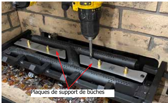
Schéma 5 - Installer les plaques de support des bûches
