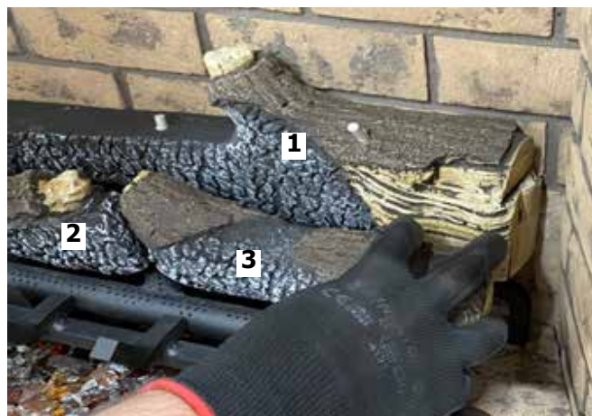
Schéma 8 - Installation de la bûche 3
