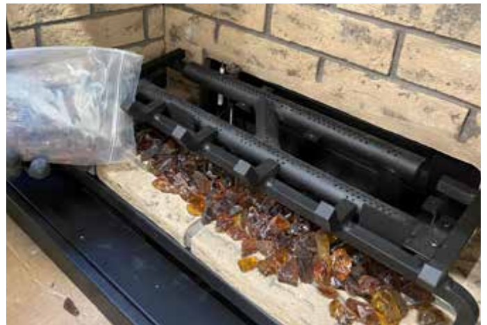
Schéma 3 - Installer les cristaux de verre
