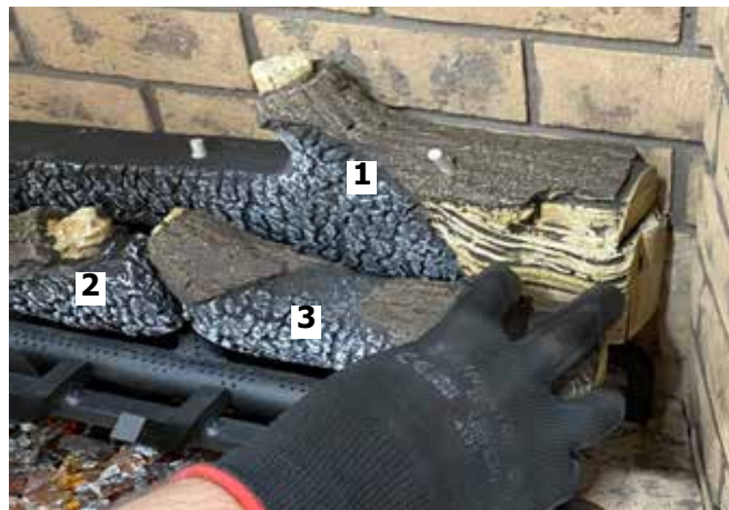
Schéma 8 - Installation de la bûche 3
