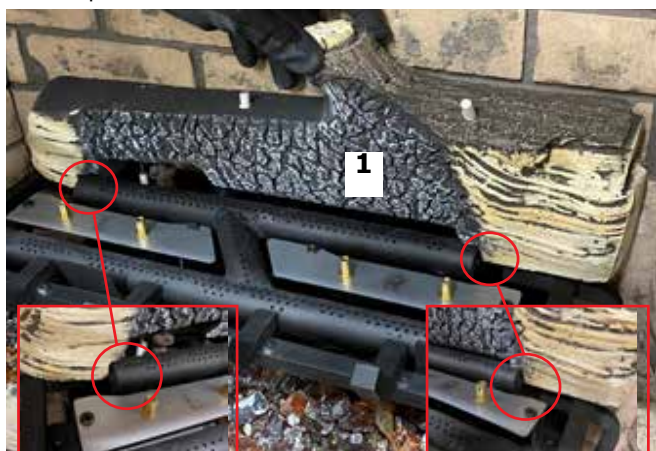
Schéma 6 - Installation de la bûche 1
