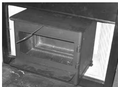
Schéma 5 Tige de traction en place
