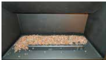
1) Commencer par installer les cristaux à l'arrière du brûleur et du plancher de la chambre de combustion
