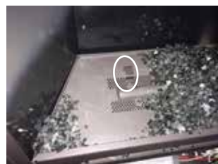
Modèle HZ33CE - Installer la fixation sur la gauche
