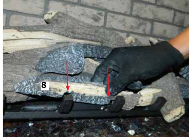
Schéma 14 - Installation de la bûche 8
