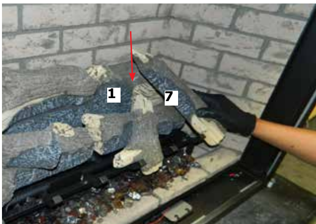
Schéma 13 - Installation de la bûche 7
