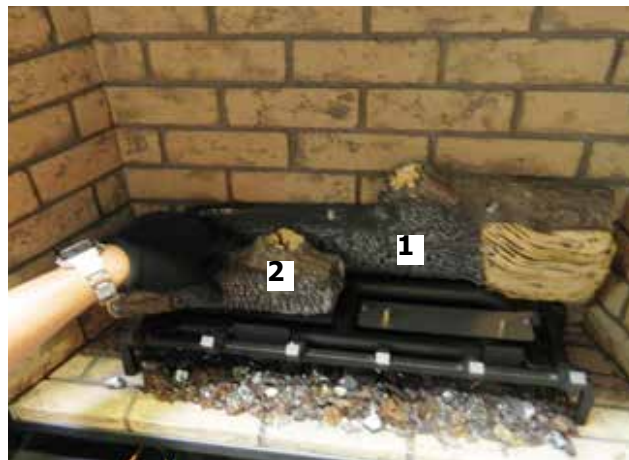
Schéma 8 - Installation de la bûche 2
