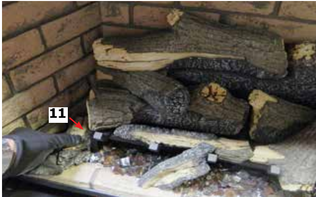
Schéma 17 - Installation de la bûche 11
