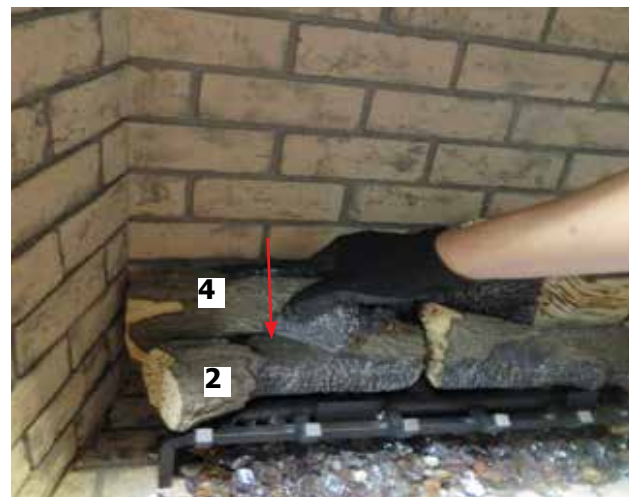
Schéma 10 - Installation de la bûche 4
