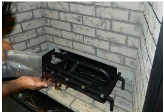
Schéma 3 - Installer les cristaux de verre
