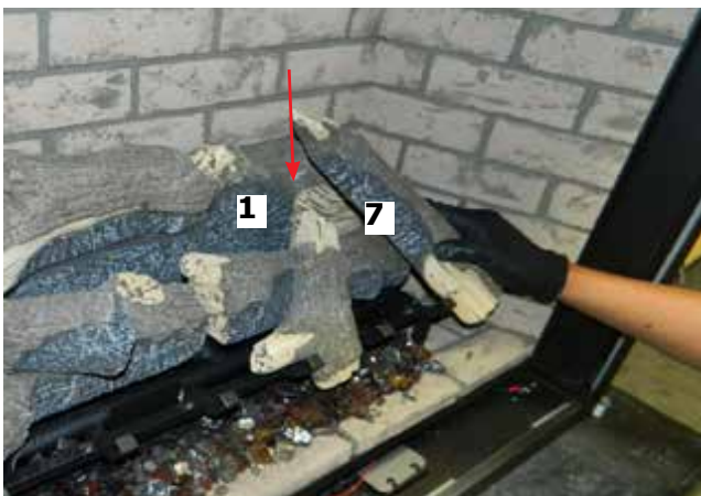
Schéma 13 - Installation de la bûche 7
