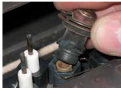
Schéma 2 : Faire glisser le dispositif du brûleur vers la droite, puis l'enlever.
