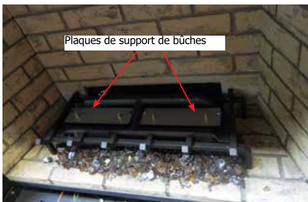
Schéma 6 - Plaques de support de bûches installées
