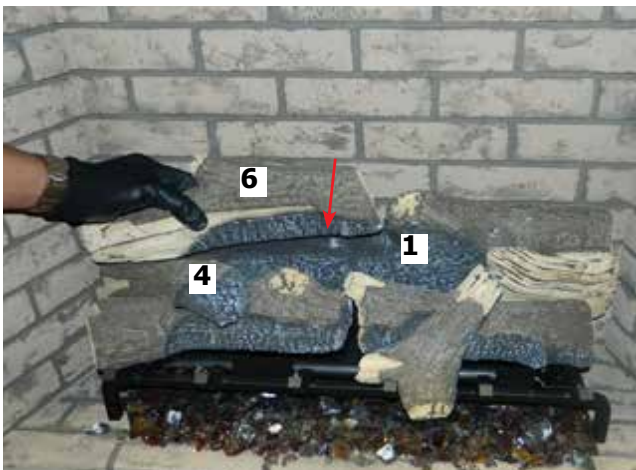
Schéma 12 - Installation de la bûche 6
