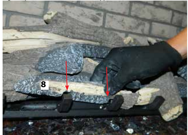
Schéma 14 - Installation de la bûche 8
