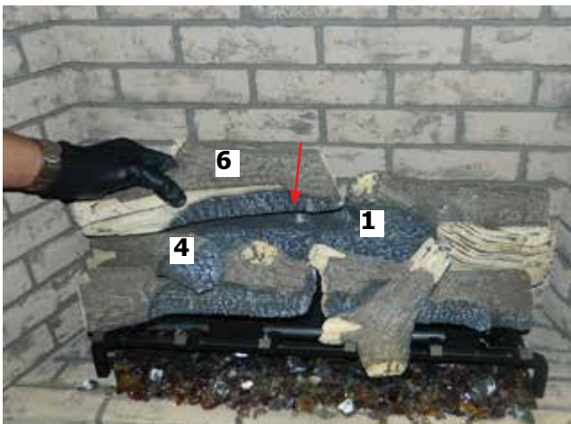
Schéma 12 - Installation de la bûche 6
