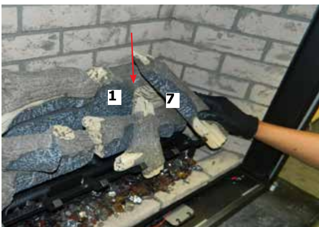
Schéma 13 - Installation de la bûche 7
