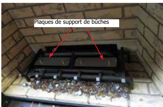
Schéma 6 - Plaques de support de bûches installées
