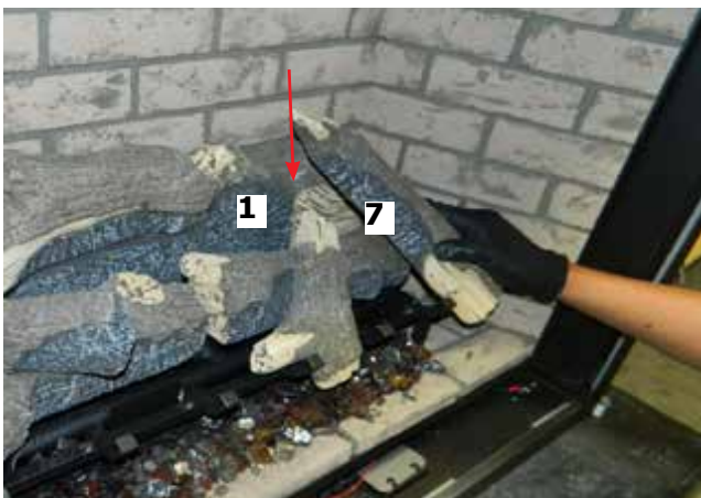
Schéma 13 - Installation de la bûche 7
