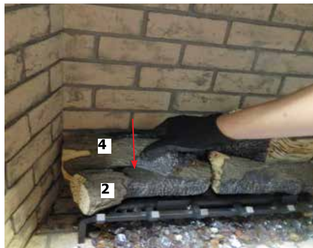
Schéma 10 - Installation de la bûche 4
