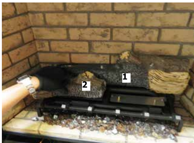
Schéma 8 - Installation de la bûche 2
