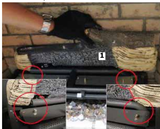
Schéma 7 - Installation de la bûche 1
