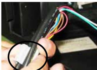
15) Glisser le module du thermodisque le long de la pince fixée sur le dessous du trappe d'accès du ventilateur.
