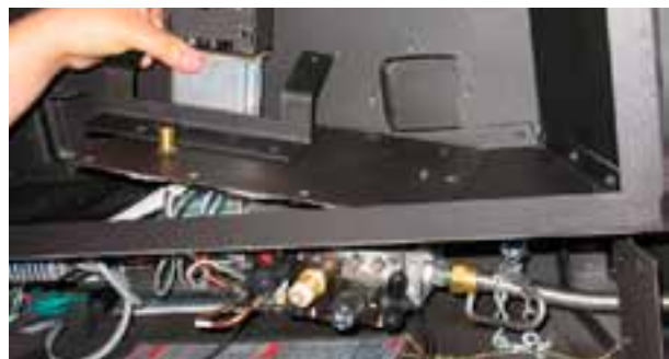
Schéma 5: soulever le plateau de la soupape
