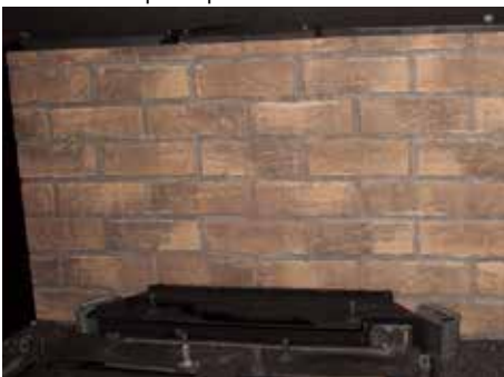
Panneau du fond une fois installé
