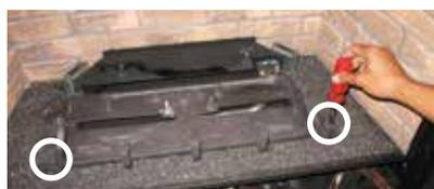
Schéma 1 : Dévisser les deux vis du brûleur situées sur la gauche et sur la droite.
