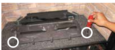
Schéma 1 : Dévisser les deux vis du brûleur situées sur la gauche et sur la droite.
