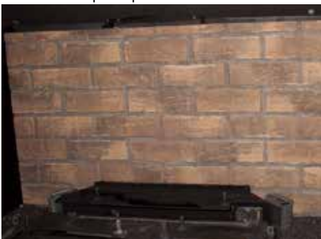
Panneau du fond une fois installé
