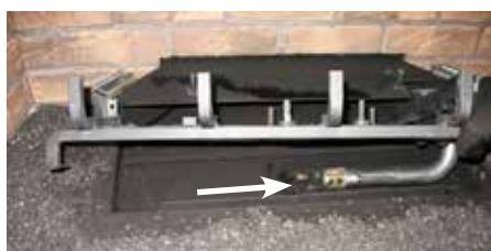
Schéma 2 : Glisser le brûleur vers la droite puis le soulever
