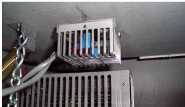
10. Installer le module de commande du ventilateur (FCM) sur le côté gauche de la base de l'appareil et le brancher à la prise électrique de l'appareil comme indiqué.
