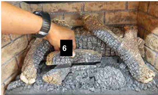
Installation de la bûche 6
