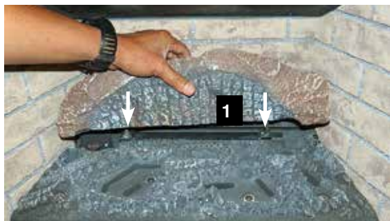
Installation de la bûche 1
