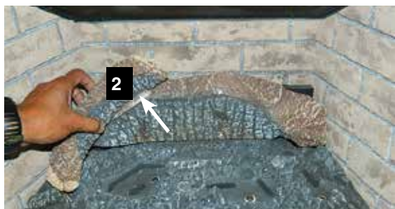
Installation de la bûche 2
