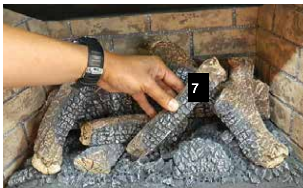
Installation de la bûche 7
