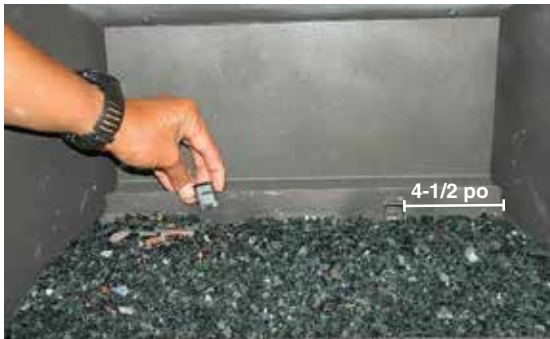
Installation de la fixation pour les bûches
