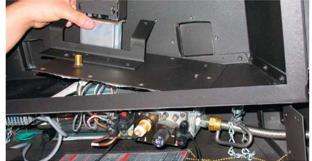
Schéma 5: soulever le plateau de la soupape
