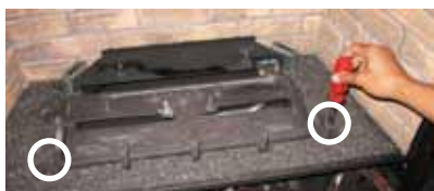
Schéma 1: Dévisser les deux vis du brûleur.
