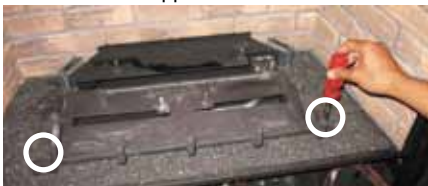
Schéma 1: Dévisser les deux vis de chaque côté du brûleur.
