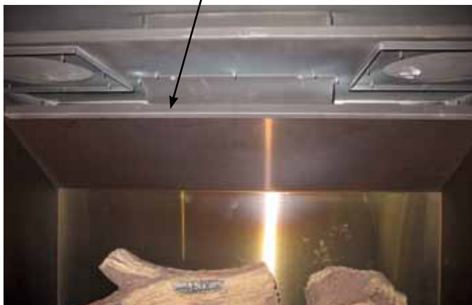
la ferrure de fixation supérieure installé avec les panneaux en acier inoxydable
