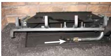
Schéma 2: Glisser le brûleur vers la droite et le soulever.
