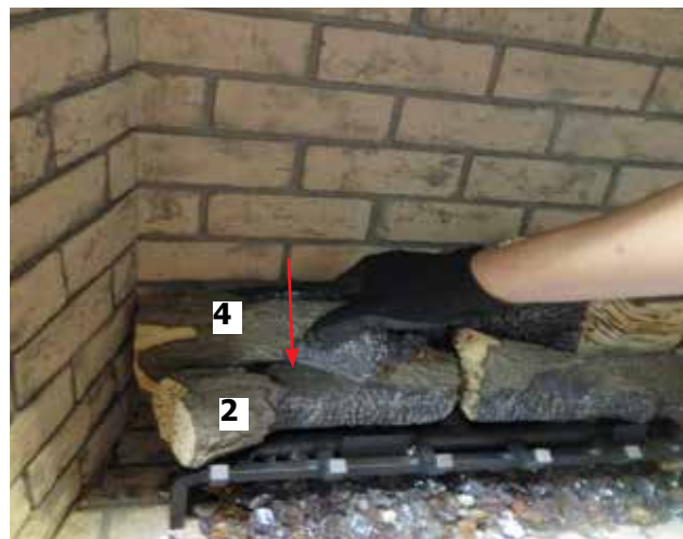
Schéma 10 - Installation de la bûche 4
