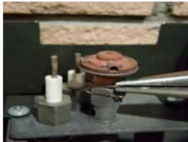
8. Retirer le capuchon de la veilleuse pour exposer l'orifice de la veilleuse.
