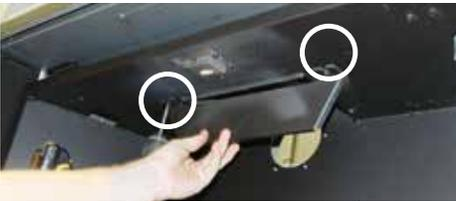
3. Desserrer les deux vis sur le dispositif de la veilleuse dans les emplacements indiqués ci-dessous. Glisser la protection de la veilleuse vers le mur du fond puis la retirer de l'appareil.
