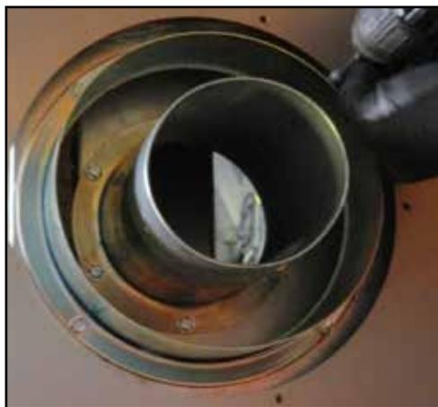
12. Réinstaller la plaque d'évacuation (retirée à l'étape 1) avec six (6) vis.
