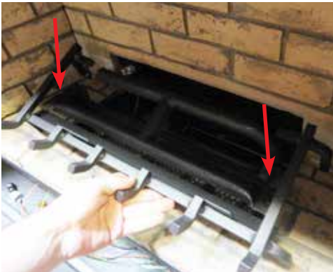
Schéma 1: Retirer les vis de gauche et de droite.
