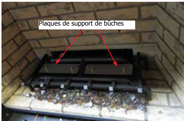
Schéma 6 - Plaques de support de bûches installées
