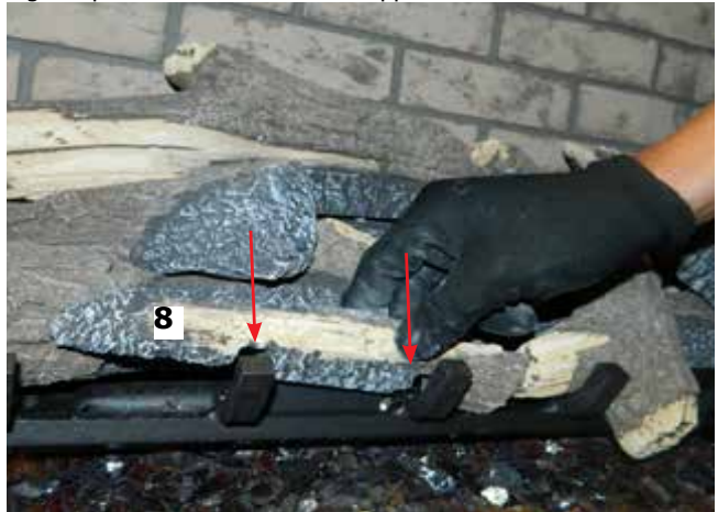
Schéma 14 - Installation de la bûche 8
