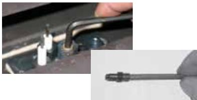
10. Réinstaller le capuchon de la veilleuse et la pince de la veilleuse.
