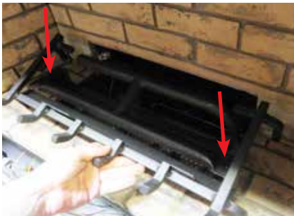
Schéma 1: Retirer les vis de gauche et de droite.
