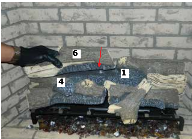
Schéma 12 - Installation de la bûche 6
