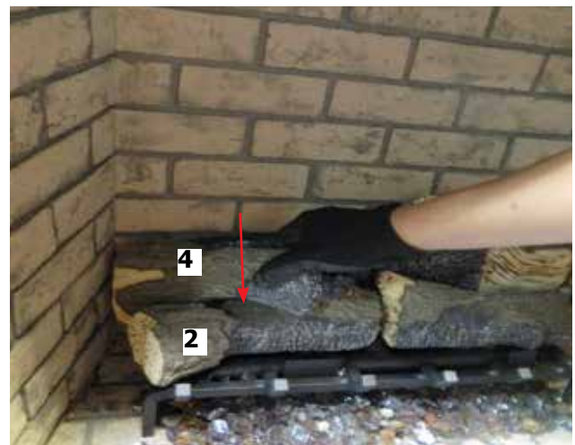
Schéma 10 - Installation de la bûche 4
