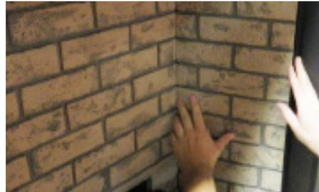
7. Une fois le panneau en place, le fixer à l'aide de l'attache à briques retirée à l'étape 5 et serrer la vis.
