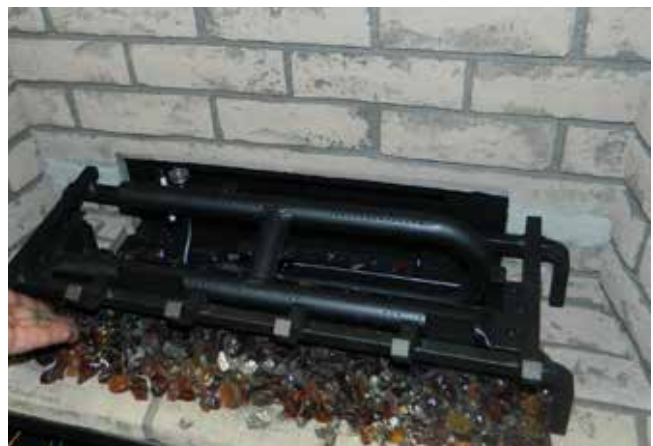
Schéma 4 - Installer la vermiculite et la lave
