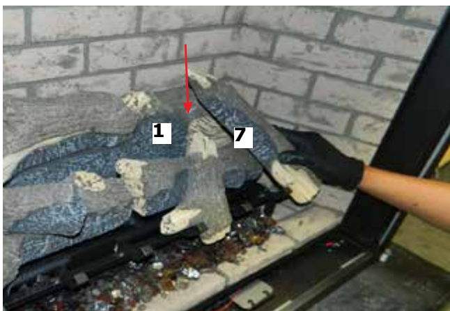
Schéma 13 - Installation de la bûche 7
