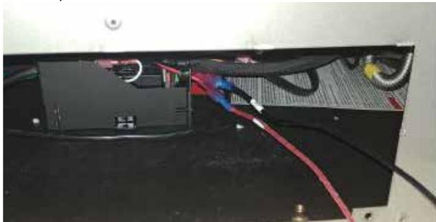
5. Raccorder le câble de mise à la terre du ventilateur à la prise de terre (située dans le coin inférieur droit de l'appareil). Se reporter au schéma de câblage.
