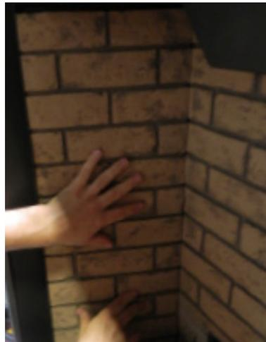
9. Glisser soigneusement le panneau inférieur sous le brûleur et le pousser vers l'arrière jusqu'à ce qu'il entre en contact avec le panneau arrière.
