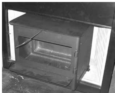
Tige de traction en place
