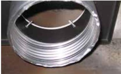
Fixer la plaque supérieure de connexion à la chambre de combustion à l'aide de 4 vis.
