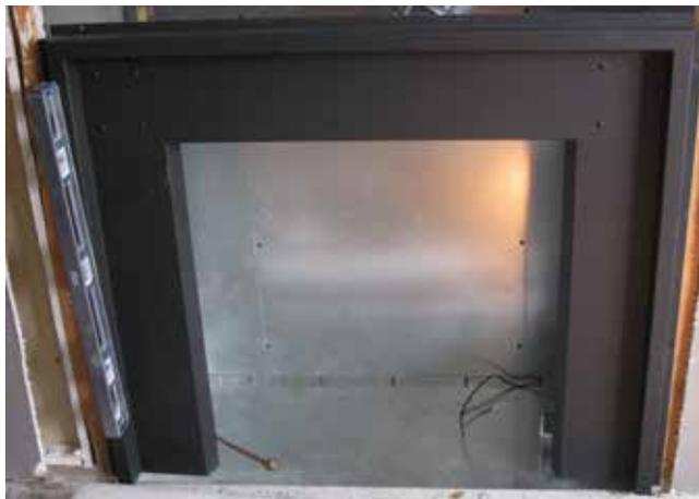
17. Régler les pattes extérieures de la chambre de combustion du modèle E18E comme illustré ci-dessous.
