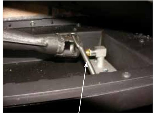
Câble de réglage de l'arrivée d'air
