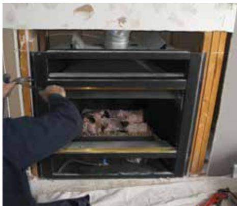
*Retirer l'appareil de la structure*
