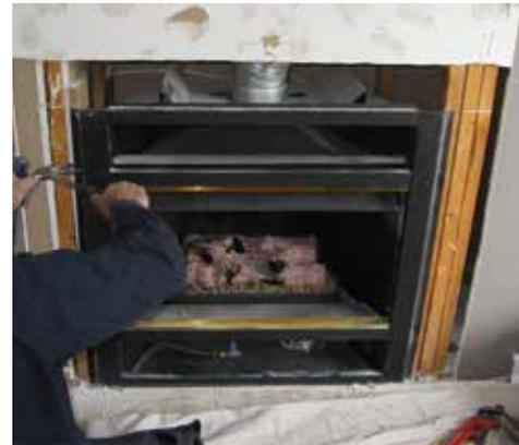
*Retirer l'appareil de la structure d'encadrement*
