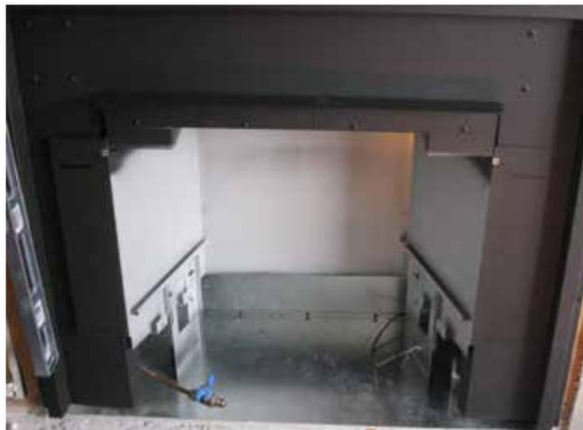
Illustration de la chambre de combustion extérieure en place - se reporter aux mesures (étape 18) avant de fixer le contour.
