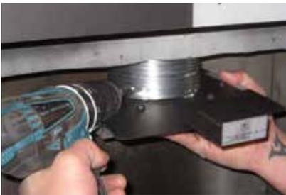
Fixer la plaque coulissante au conduit flexible à l'aide de 4 vis.
