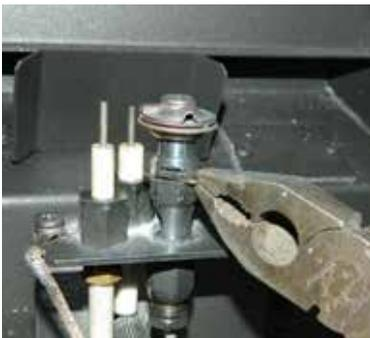
8. Dégager la coiffe de la veilleuse pour exposer l'orifice de la veilleuse.
