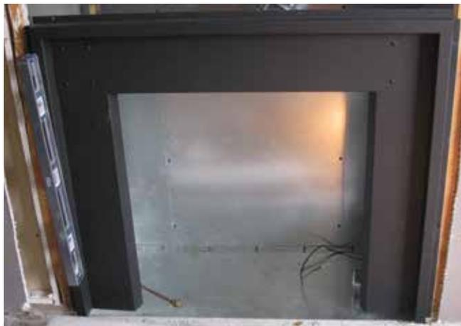
5. Séparer les chambres de combustion interne et externe du modèle E18E - se reporter à la section sur l'installation dans un appareil existant dans le présent manuel pour plus de détails.
