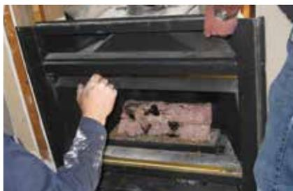
10. Mesurer l'ouverture de la structure et la comparer aux dimensions requises. Des ajustements supplémentaires à l'ouverture peuvent être nécessaires.
