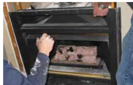
10. Mesurer l'ouverture et comparer ces mesures avec les exigences requises. Des réglages supplémentaires au niveau de l'ouverture de l'encadrement peuvent être nécessaires.
