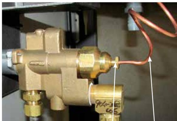
Schéma 3      Loosen nut      Thermocouple
