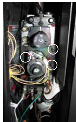
Retirer le moteur pas-à-pas pour gaz naturel et le remplacer par le moteur pas-à-pas pour propane
